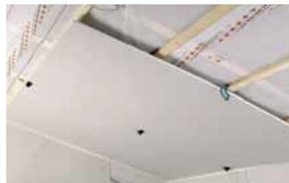
Las herramientas y pinzas prácticas aseguran un montaje seguro, sencillo en paredes, techos y, en especial, superficies inclinadas. Las pinzas y crucetas de sujeción se quitan de nuevo una vez atornilladas fijamente todas las piezas, pudiendo utilizarse entonces en otras planchas
